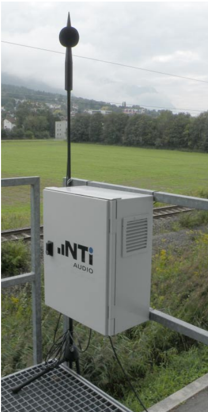
Lärm-Messstation mit Aussenmikrofon und Dreibein
