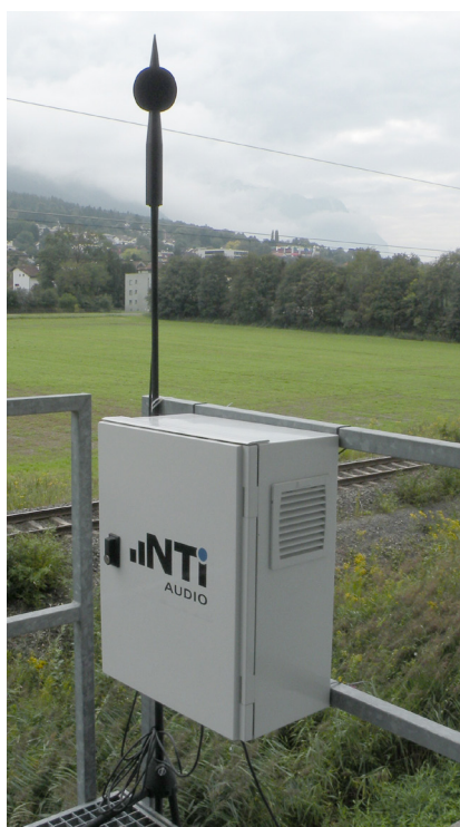
Station de surveillance du bruit IP55 avec microphone d'extérieur monté sur trépied
